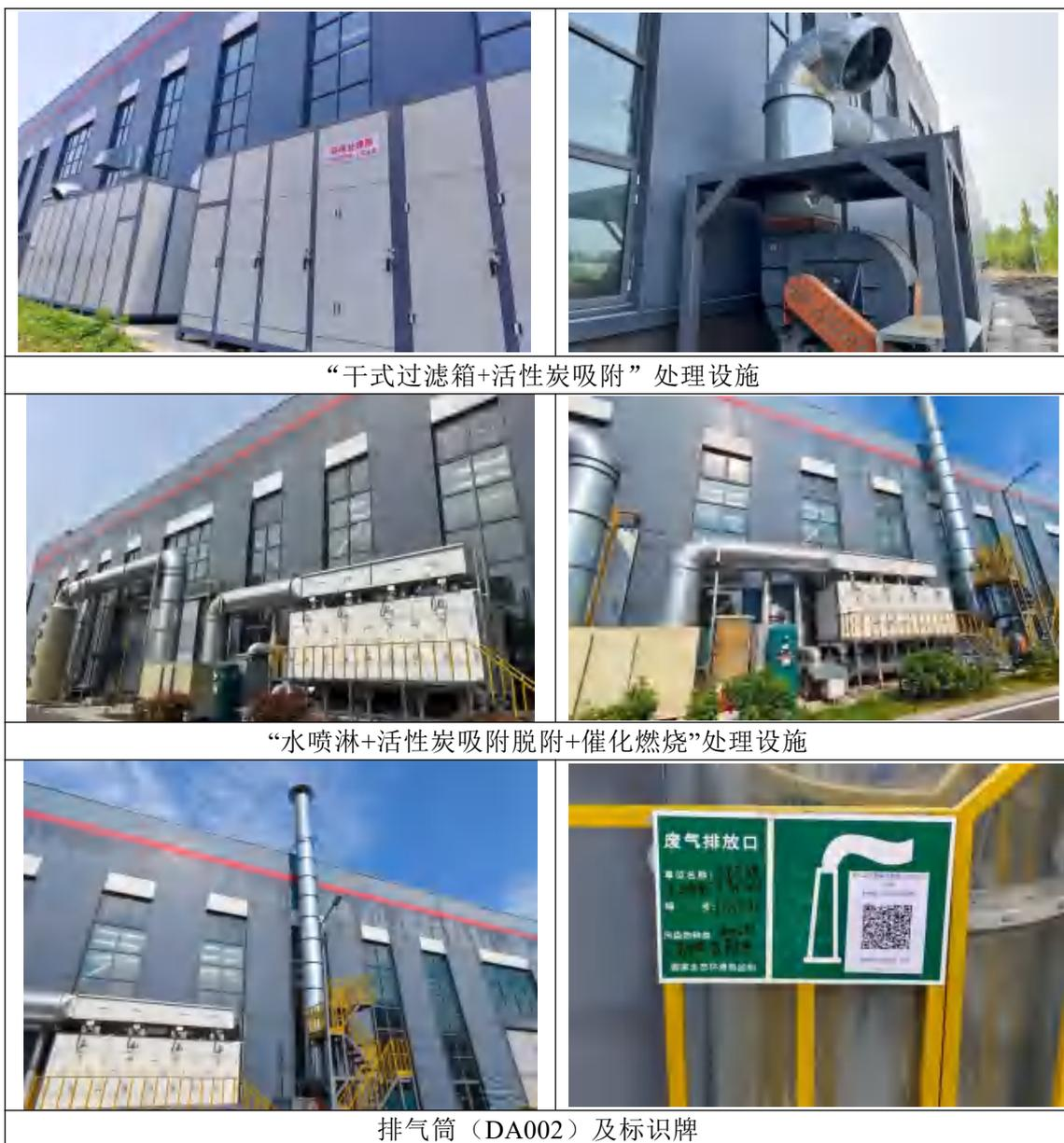
图 4.1.2 废气处理设施实际建设情况
